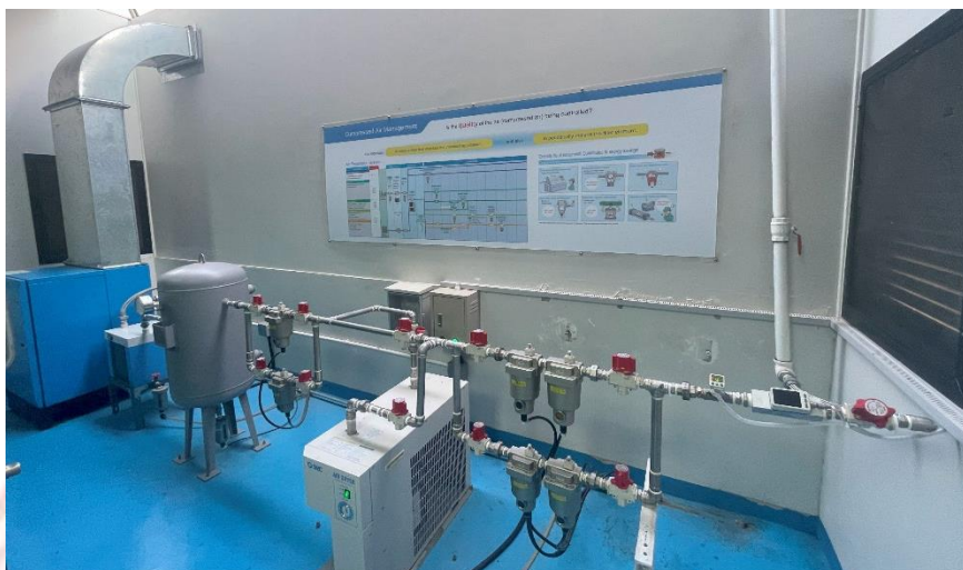
ภาพที่ 2-1 การจำลองระบบปรับอากาศในโรงงานอุตสาหกรรม
