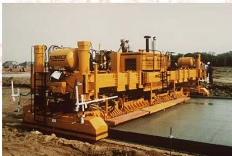
ภาพที่ 2-19 เครื่องปูคอนกรีต (Slip-Form Paver) (Stevenson, 2021)
