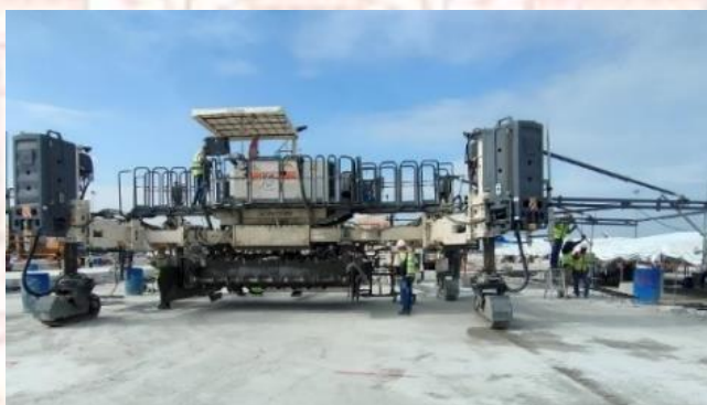
ภาพที่ 4-14 เครื่องปูคอนกรีต Slip-Form Paver
