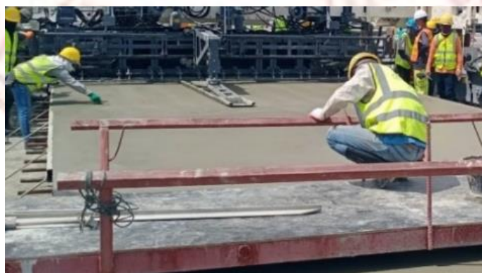
ภาพที่ 3-8 งานแต่งผิวหน้าคอนกรีตด้วย Auto Float และทีมแต่งผิวหน้าเรียบ (พงศธร และ กมลวัลย์, 2567)
