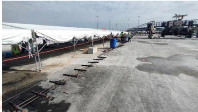
ภาพที่ 3-6 Slip-Form Paver เข้าตำแหน่ง และยกแผง Transverse Joint ออกมาด้านข้าง (พงศธร และ กมลวัลย์, 2567)
