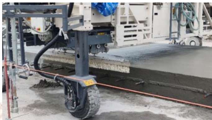
ภาพที่ 3-9 สร้างลายผิวหน้าและฉีดพ่นน้ำยาบ่มคอนกรีตด้วย Texture and Curing Machine (พงศธร และ กมลวัลย์, 2567)
