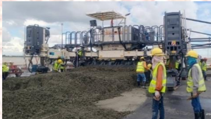
ภาพที่ 3-7 การปูผิวทางคอนกรีตด้วย Slip-Form Paver (พงศธร และ กมลวัลย์, 2567)
