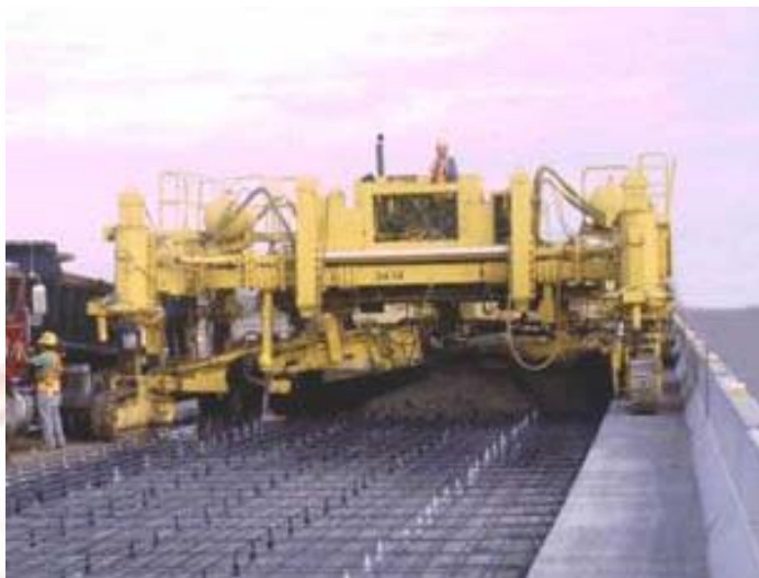
ภาพที่ 2-21 พื้นที่สำหรับล้อตีนตะขาบของเครื่องปูคอนกรีต (Stevenson, 2021)
