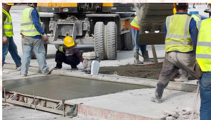
ภาพที่ 3-11 แต่งผิวหน้าด้วยคานสั่นปาดหน้าคอนกรีต
