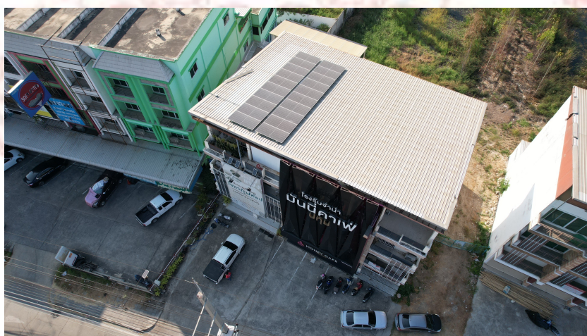
รูปที่ 3.2 รูปแผง โซลาร์ เซลล์ ขนาด 550W. จำนวน 20 แผง.
