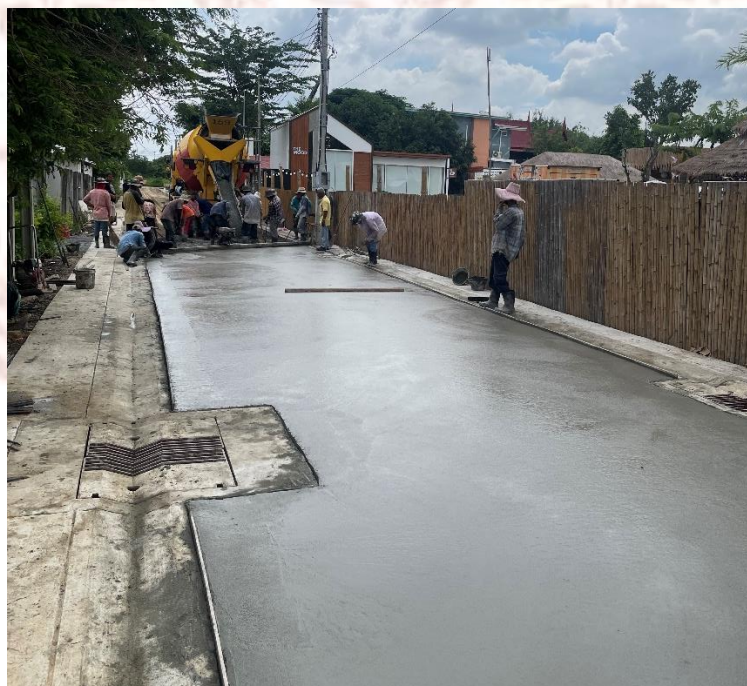
ภาพที่ 2-5 ขั้นตอนการเทคอนกรีตผิวถนน โครงการปรับปรุงถนนซอยรามอินทรา 97 แยก 3-2
