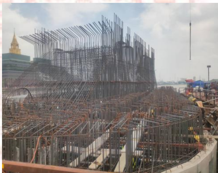
ภาพที่ 2-8 การเสริมเหล็กฐานรากสะพาน
