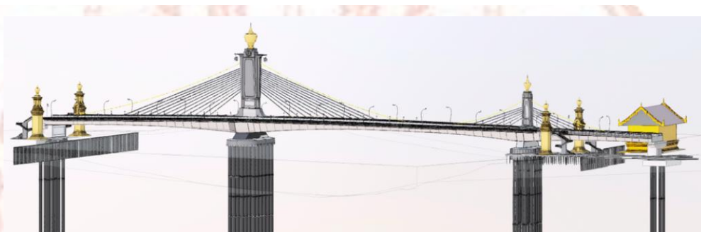
ภาพที่ 2-5 ระบบโครงสร้างของสะพานข้ามแม่น้ำเจ้าพระยา บริเวณแยกเกียกกาย
