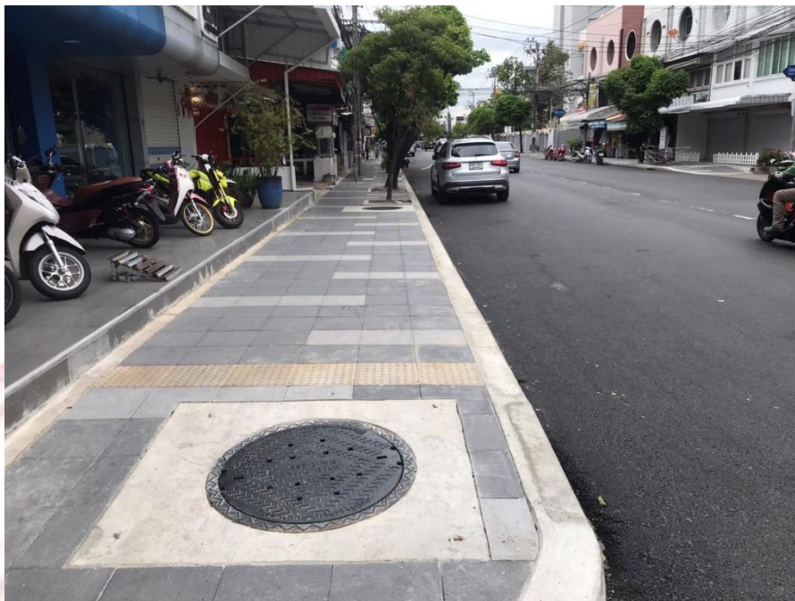
ภาพที่ 2-4 รูปแบบทางเท้าหลังได้รับการปรับปรุง โครงการปรับปรุงทางเท้าถนนโชคชัย 4
