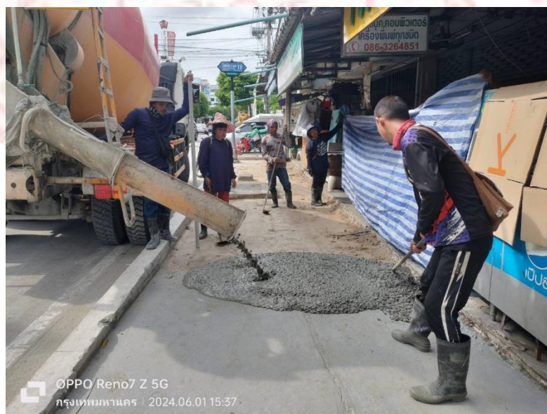
ภาพที่ 2-3 ขั้นตอนการเทพื้นฐานทางเท้า ก่อนการปูกระเบื้อง
