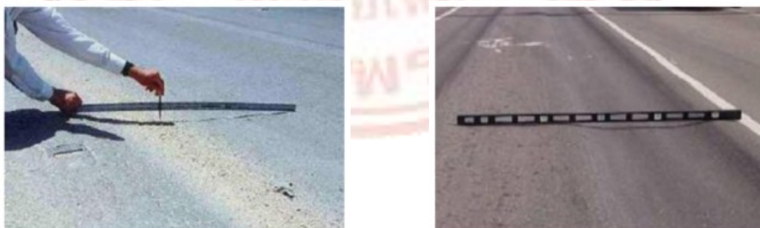
ภาพที่ 2-3 ความเสียหายประเภทร่องล้อ
