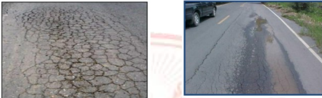
ภาพที่ 2-8 ความเสียหายประเภทรอยแตกร้าวแบบหนังจระเข้
