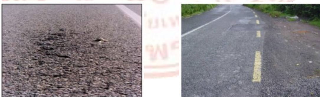
ภาพที่ 2-5 ความเสียหายประเภทผิวทางหลุดร่อน
