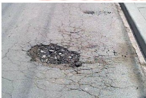
ภาพที่ 2-1 ความเสียหายประเภทหลุมบ่อ
