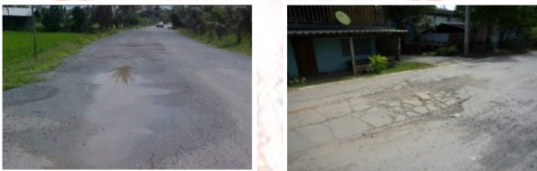
ภาพที่ 2-2 ความเสียหายประเภทยุบตัวเป็นแอ่ง
