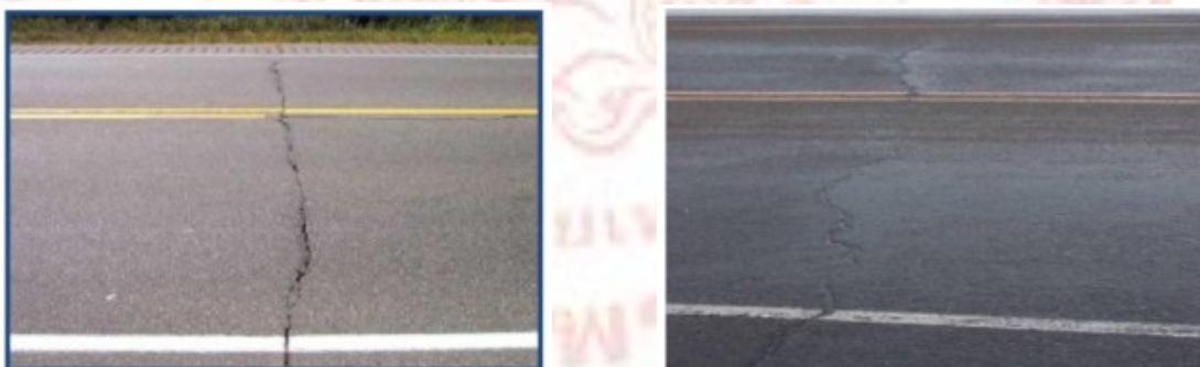
ภาพที่ 2-7 ความเสียหายประเภทรอยแตกร้าวตามแนวขวาง
