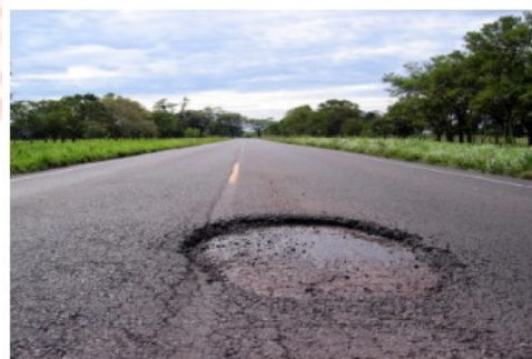
ภาพที่ 2-1 ความเสียหายประเภทหลุมบ่อ
