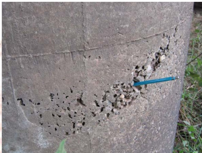
ภาพที่ 2-16 ภาพแสดงการเกิดรูพรุนเหมือนรวงผึ้ง
