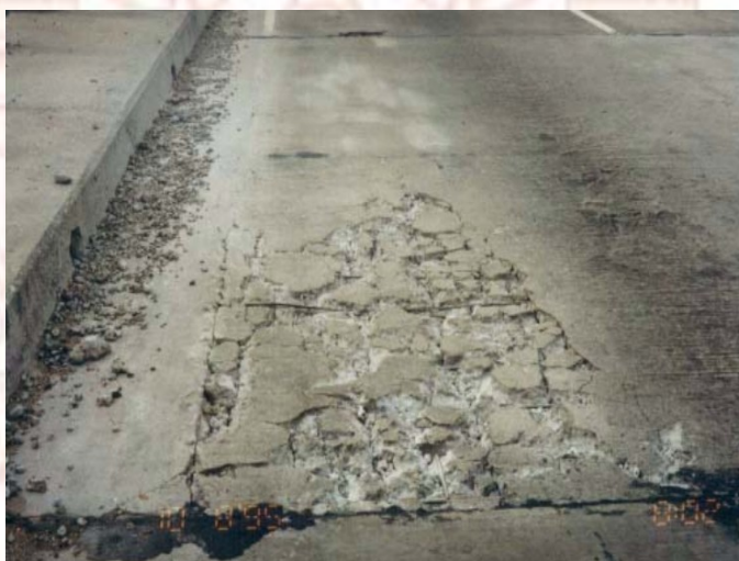
ภาพที่ 2-20 ภาพแสดงการเสียหายอย่างรุนแรงที่ด้านบนของพื้นสะพาน
