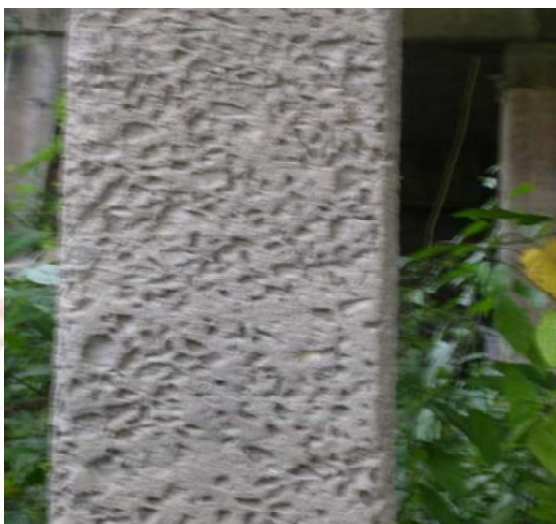
ภาพที่ 2-18 ภาพแสดงการสีกร่อนของเสาตอม่อ
