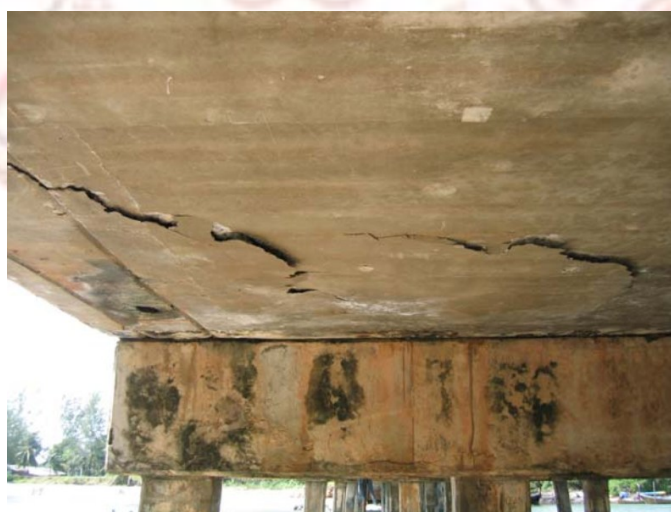
ภาพที่ 2-13 ภาพแสดงการหลุดแยกออกเป็นแผ่นๆ ใต้แผ่นพื้นสะพาน
