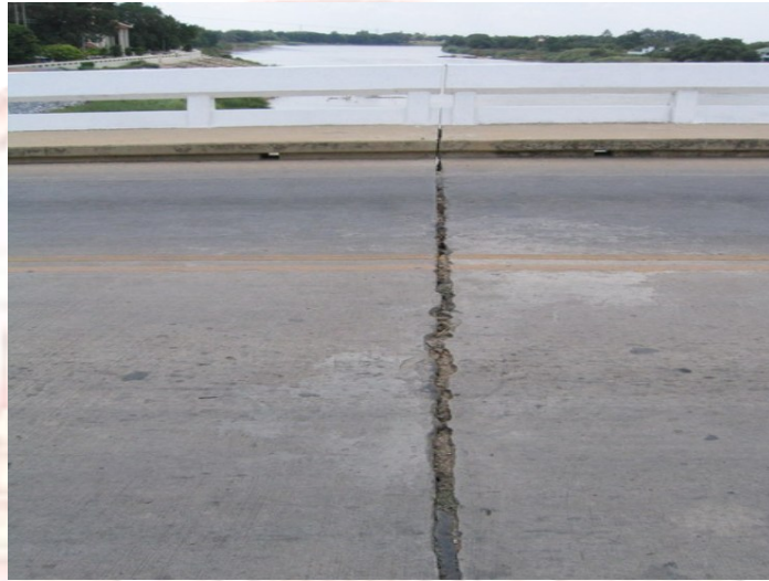
ภาพที่ 2-22 ภาพแสดงการสะสมของเศษดินที่รอยต่อเพื่อการขยายตัว
