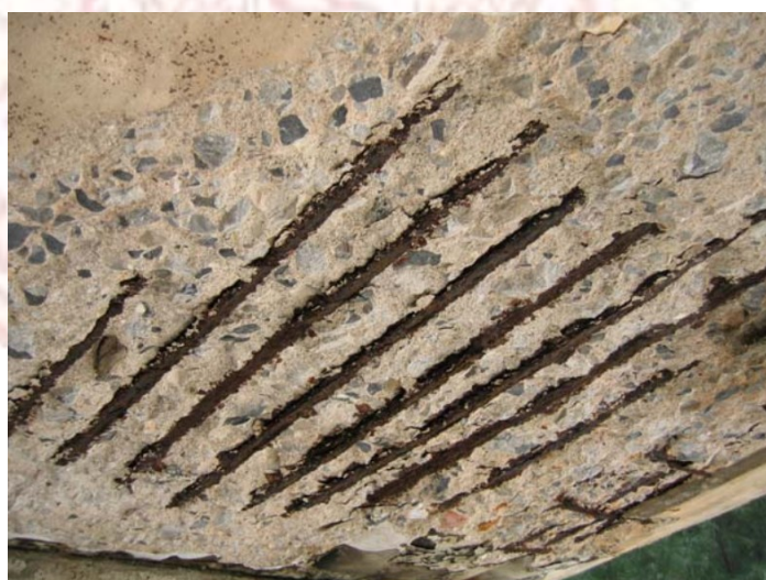
ภาพที่ 2-19 ภาพแสดงการเกิดสนิมในเหล็กเสริม
