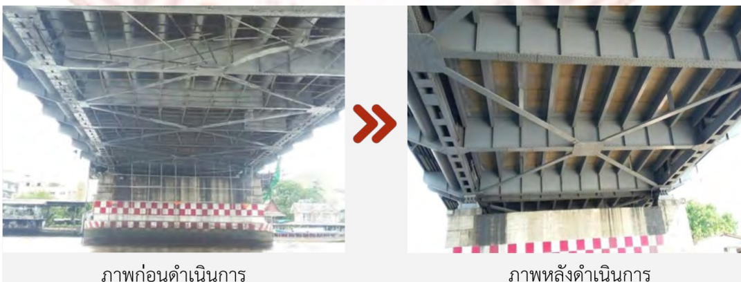
ภาพที่ 2-6 ภาพประกอบการล้างทำความสะอาดขัดสนิมทาสีโครงเหล็กช่วงล่างสะพาน
