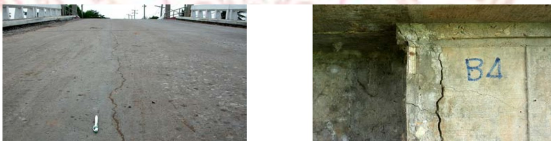
ภาพที่ 2-11 ภาพแสดงพื้นผิวสะพาน และตอม่อที่แตกร้าวเสียหาย
