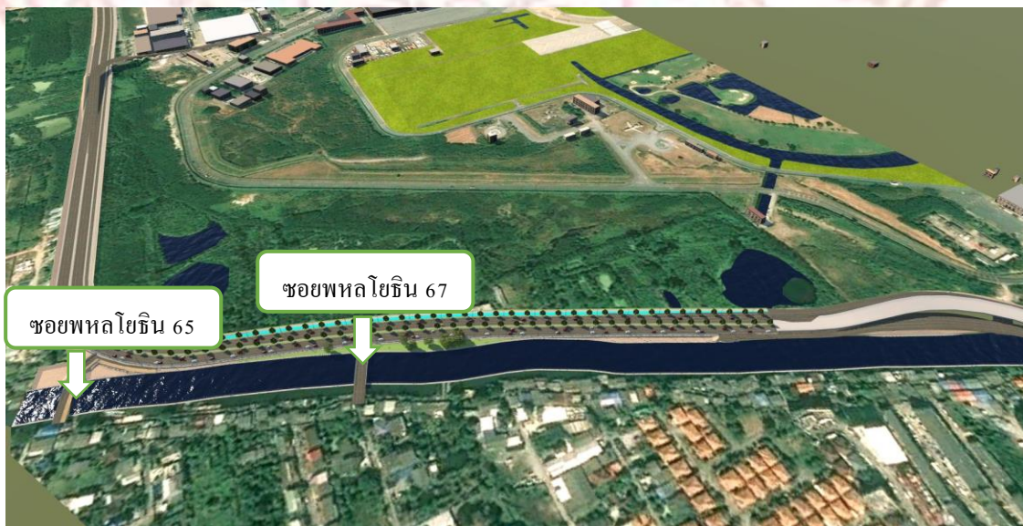
ภาพที่ 2-6 ฝั่งก่อสร้างสะพานข้ามคลอง
