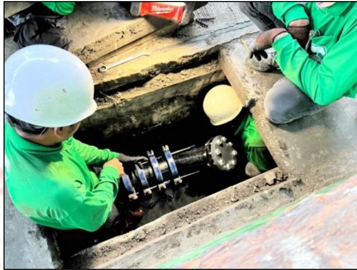
ภาพที่ 3-17 ภาพการดำเนินงานติดตั้งจุดตรวจสอบท่อส่งน้ำเสียในเส้นทางหมายเลข 4 ถึง หมายเลข 5
