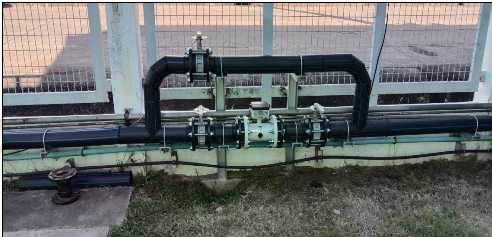
ภาพที่ 3-21 อุปกรณ์วัดอัตราการไหล (Flow Meter) รุ่น MAG5100W with MAG6000
