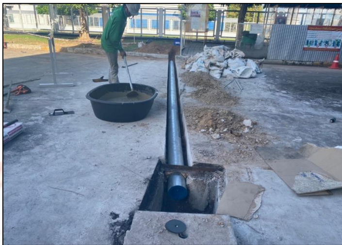
ภาพที่ 3-15 ภาพการดำเนินงานวางระบบท่อส่งน้ำเสียในเส้นทางหมายเลข 2 ถึง หมายเลข 3
