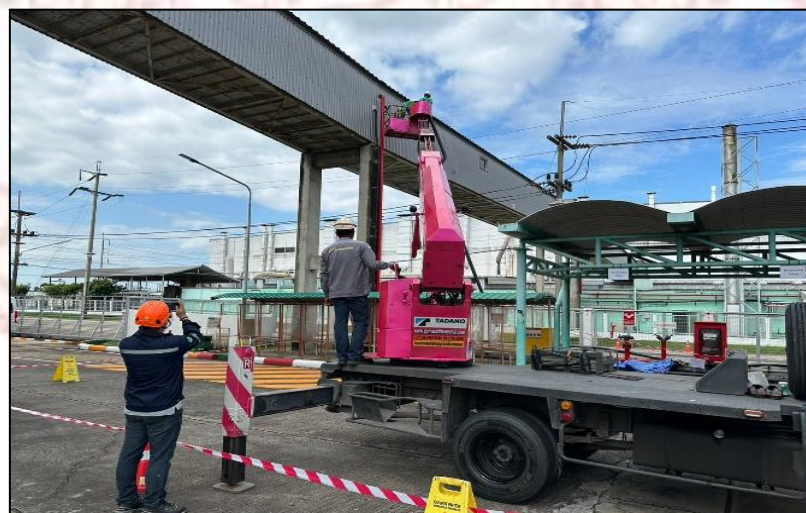
ภาพที่ 3-18 ภาพการดำเนินงานวางระบบท่อส่งน้ำเสียในเส้นทางหมายเลข 5 ถึง หมายเลข 6
