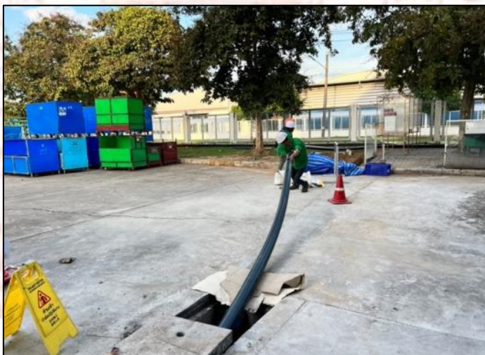
ภาพที่ 3-16 ภาพการดำเนินงานวางระบบท่อส่งน้ำเสียในเส้นทางหมายเลข 4 ถึง หมายเลข 5
