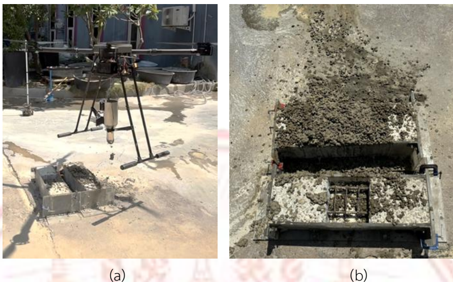
ภาพที่ 4-20 การเทคอนกรีตด้วยโดรนโดยการปล่อยอิสระ (a) ขณะเทคอนกรีต (b) หลังเทคอนกรีตเสร็จ
