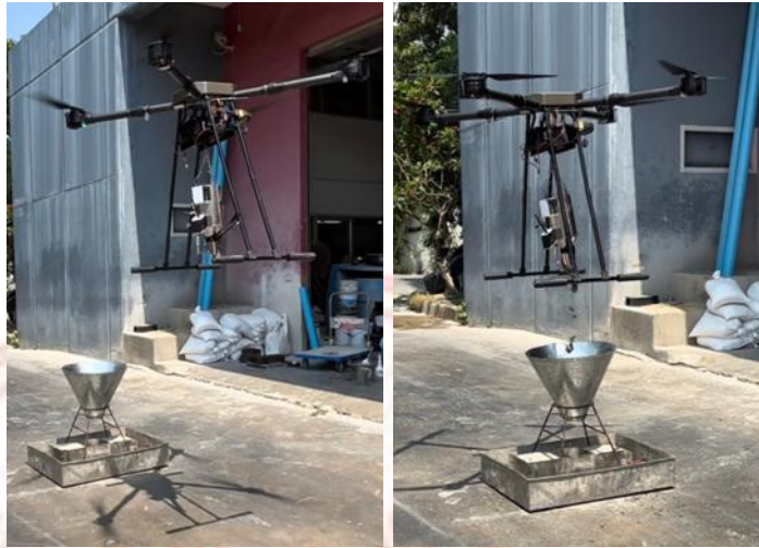
ภาพที่ 4-29 โดรนขณะเทคอนกรีตของแบบหล่อคานซ่อมแซม
