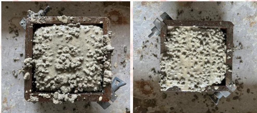
ภาพที่ 4-22 หลังจากการเทคอนกรีตด้วยโดรนในแบบหล่อลูกบาศก์
