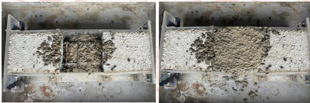
ภาพที่ 4-30 หลังจากการเทคอนกรีตด้วยโดรนในแบบหล่อคานซ่อมแซม
