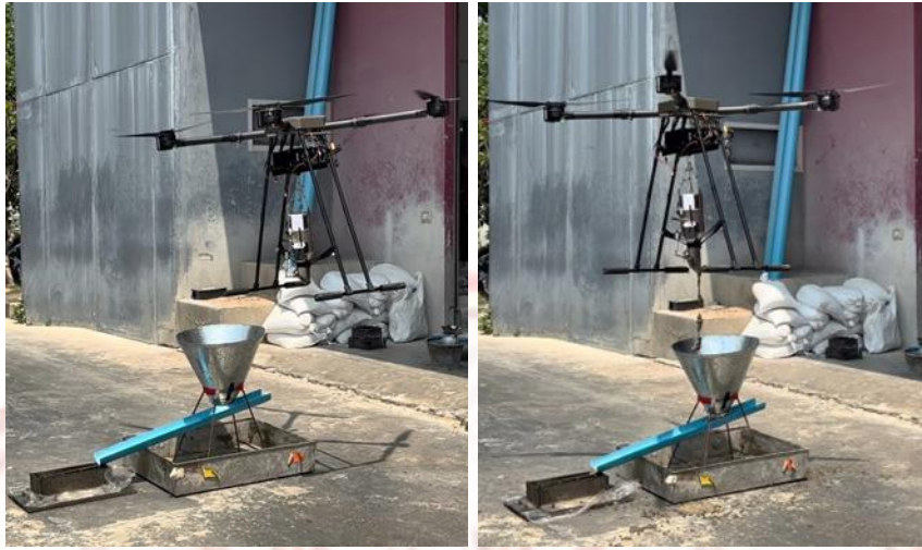
ภาพที่ 4-25 โดรนขณะเทคอนกรีตของแบบหล่อคาน
